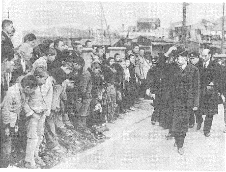
地方巡幸第1日の昭和21年2月19日、神奈川県の川崎や横浜に、いくつかの工場や共同住宅などを視察された。
