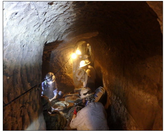
壕内作業の状況
