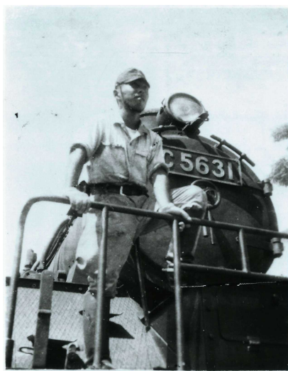
建設工事中の菅野さんとC5631号
